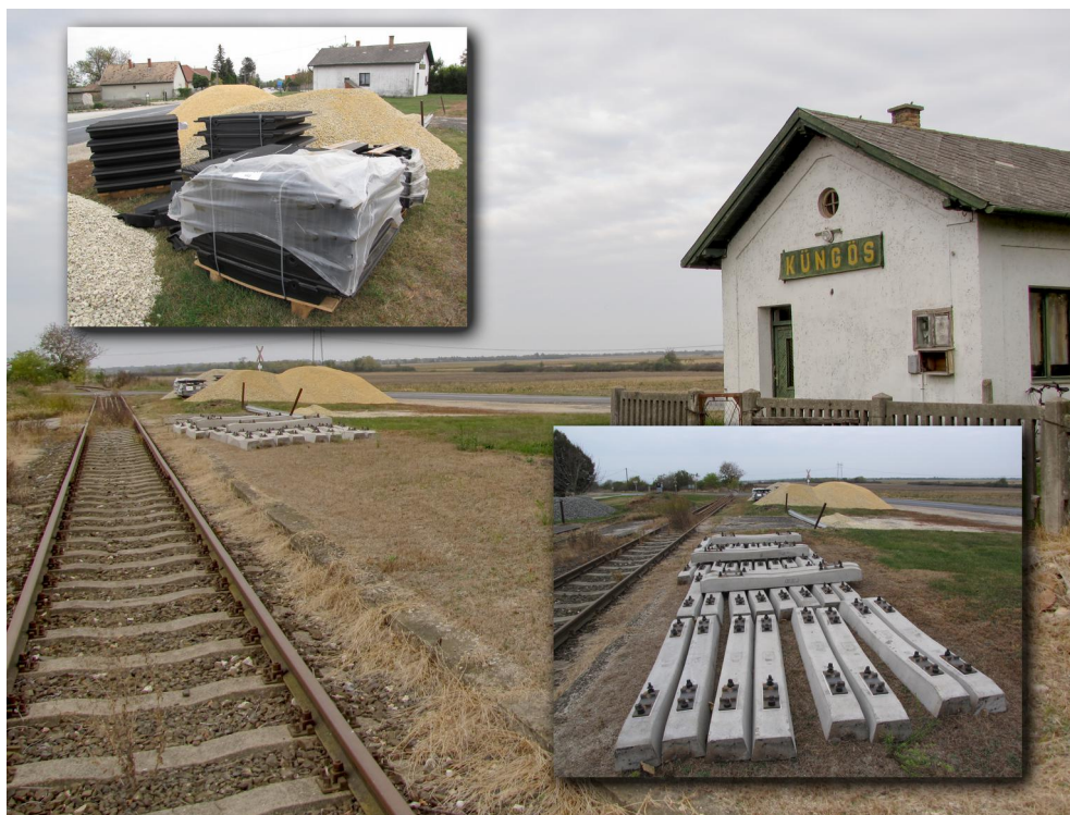
Hamarosan beépítésre váró anyagok a 11 éve szünetelő vasútvonalon.
