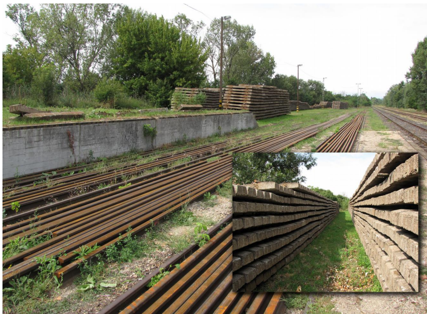
Papkeszi állomásra felhalmozott vasúti anyagok. A leromlott pályaállapotok innentől kezdődnek, ahová szükséges lenne a beépítésük.
